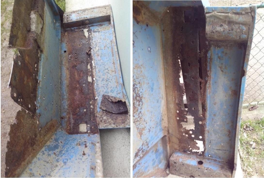
Slika 4: Korozija na spodnji strani blatnika in korozija na zunanji strani blatnika Vir: Berghaus 2020
