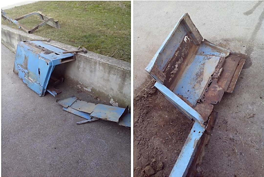
Slika 3: Del demontiranih dotrajanih delov (levo) in demontirani blok (desno) Vir: Berghaus, 2020
