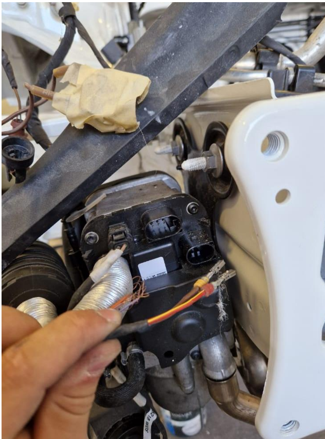
Slika 46: Poškodovana inštalacija grelca mirujočega vozila
