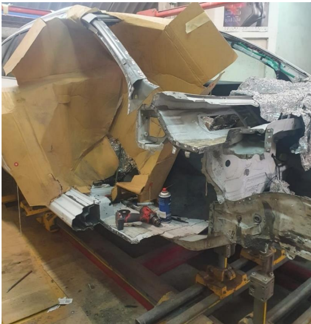
Slika 22: Pripravljena karoserija za vležišče novega karoserijskega dela
