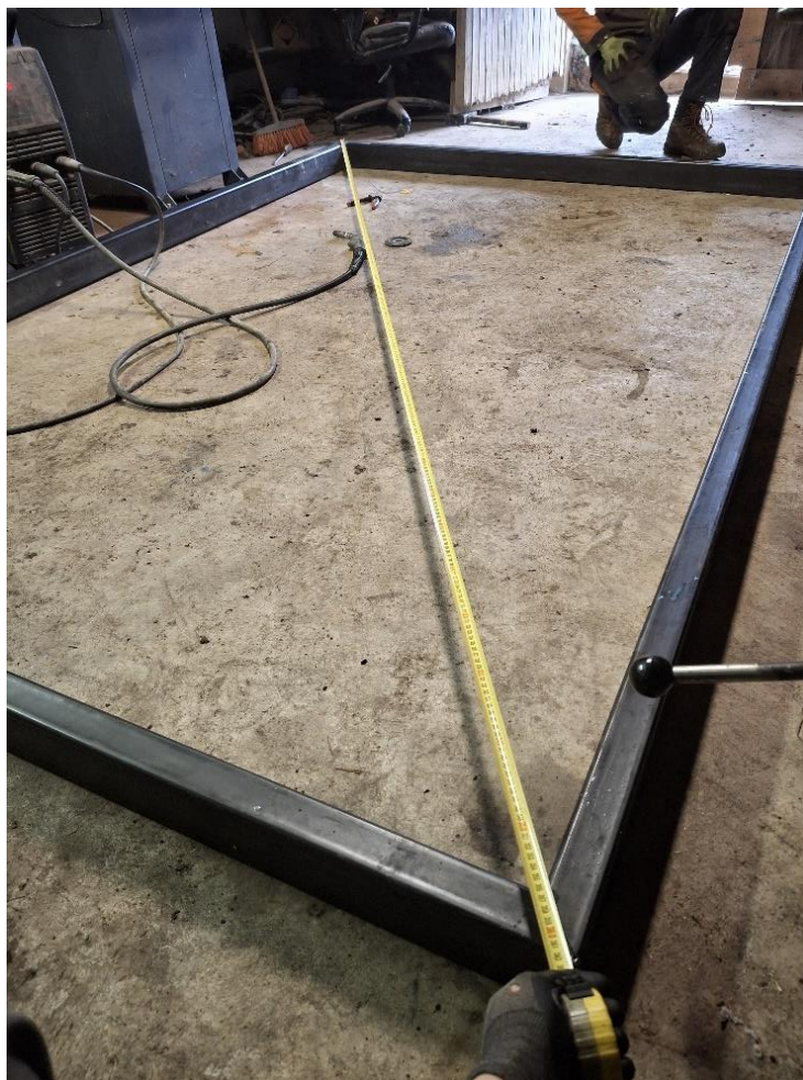
Slika 20: Točkovno varjenje in kontrola mer
